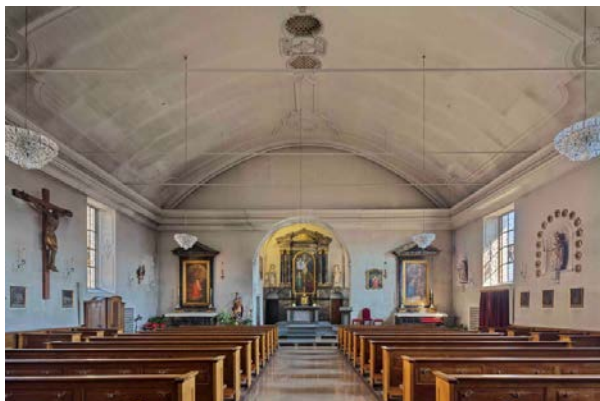
Innenraum Peterskapelle, Vorzustand
