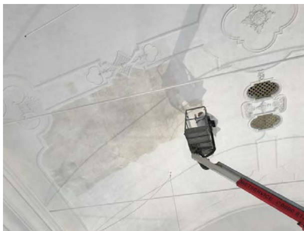
Anstrich mit Sumpfkalk am Deckengewölbe
