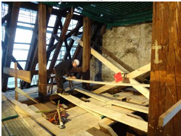
Statische Ertüchtigung Dachstuhl
