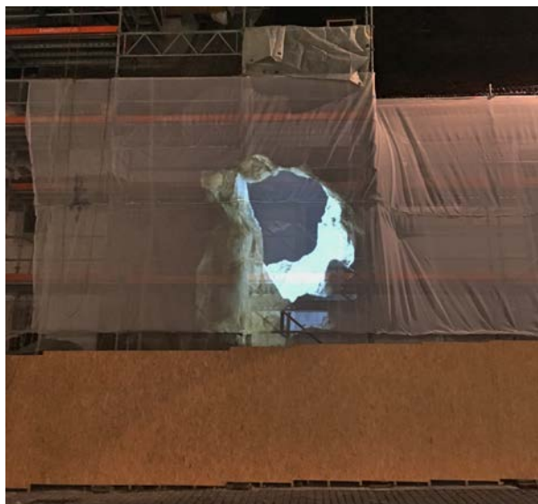
Bei den Kunstaktionen während der Bauzeit projizierte Angela Erni einen Mauerdurchbruch an die Kapelle – ein starkes Zeichen für die Herausforderung, die Peterskapelle für verschiedenste Menschen und Gruppen offenzuhalten.
