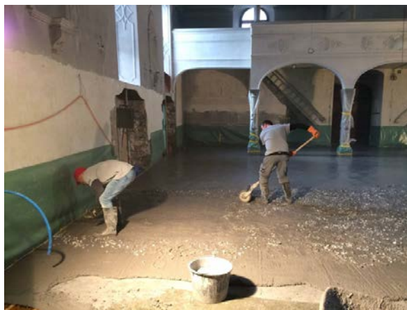
Einbau klassischer Terrazzo in Handarbeit
