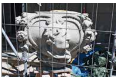
Kirchen sind oft historische Gebäude mit grossem Renovationsbedarf.
