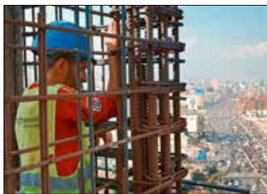
Syrischer Bauarbeiter beim Bau eines Hochhauses in Beirut. Foto: zvg
