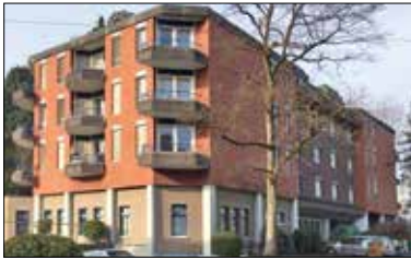
Die Liegenschaft am Matthofring 2/4, wie sie sich vor dem Umbau präsentiert.
