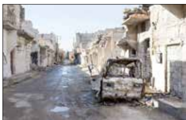
Zerstörte Häuser in Ostaleppo.
