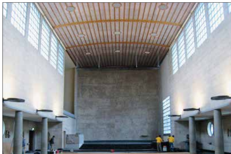
Im Inneren der Maihofkirche kurz vor der Fertigstellung. Bereits installiert sind die neuen Wandleuchten.
