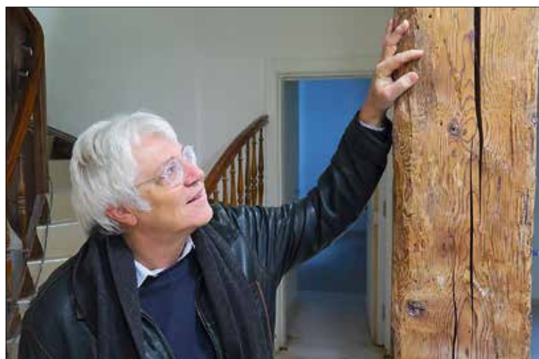
Architekt Thomas Marti zeigt einen Balken, der beim Einbau des Liftschachts entfernt und an anderer Stelle wieder eingebaut wurde. Foto: Urban Schwegler
