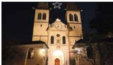
Die neue Beleuchtung der Hofkirche entspricht jetzt dem Plan Lumière.
