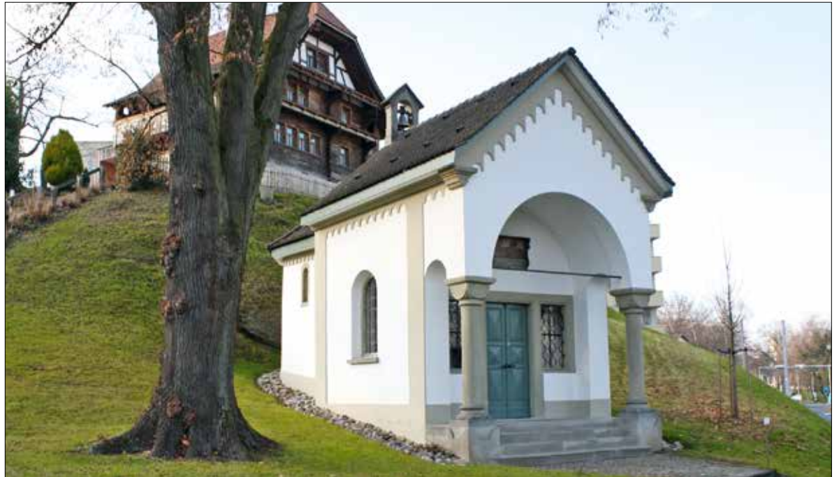
Die Kapelle Am Rain an der Langensandstrasse in Luzern wurde 2013 erneuert. Foto: Urban Schwegler
