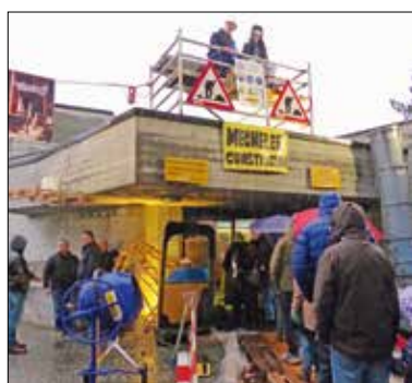
Die Mecheler verwandelten Eingang und Saal von St. Michael in eine Baustelle.
