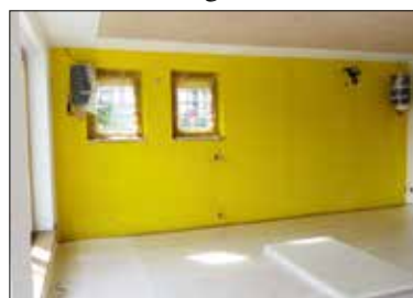
Jugi-Baustelle. Foto: Clara Wallmann
