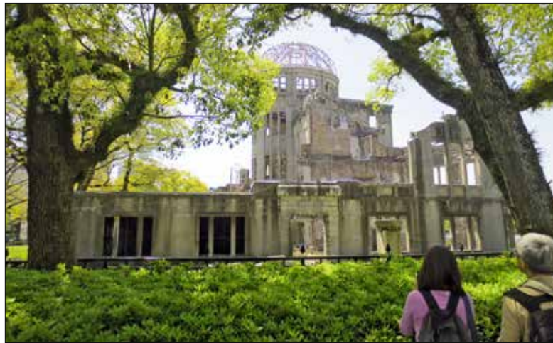
Diese Ruine in Hiroshima ist ein Mahnmal für den Atombombenabwurf.
