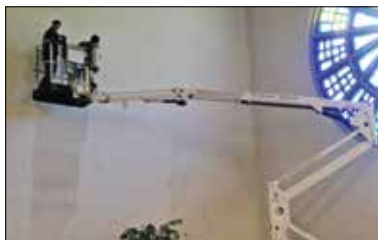
Mitarbeitende der Firma Antonini reinigen mit Hilfe eines Krans die Kirche.
