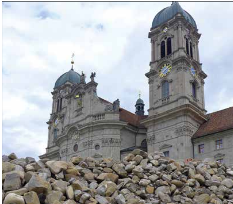
Baustelle Kirche: Steinhäufen vor dem Kloster Einsiedeln. Foto: Dominik Thali
