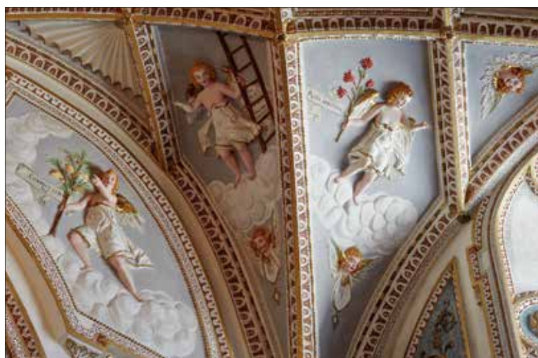
Franziskanerkirche. Gotisches Netzgewölbe der mittelalterlichen Antoniuskapelle mit Stuck von 1626, vermutlich von einem italienischen Meister. Foto: Daniela Kienzler
