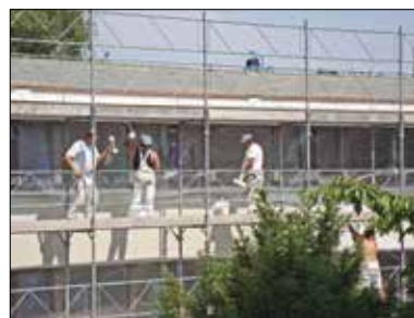
... ist nach dem Umbau und einem neuen Anstrich ...
