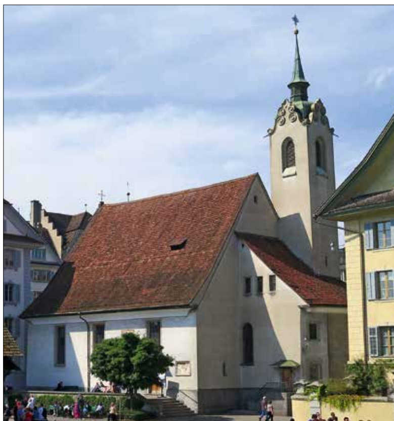
Die Peterskapelle im Herzen der Altstadt von Luzern wird erneuert. Danach kann der historisch bedeutende Kirchenraum breiter genutzt werden. Fotos: Urban Schwegler
