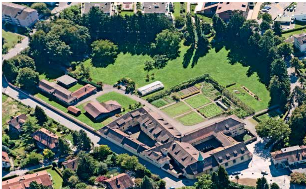
Luftbild des Klosters Wesemlin. Hier bauen die Kapuziner zurzeit an der «Oase-W». Foto: Kapuziner
