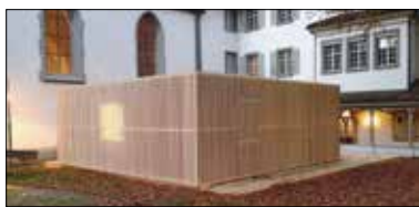
Schon jetzt in Betrieb: Provisorische Bürocontainer im Franziskanergärtli.
