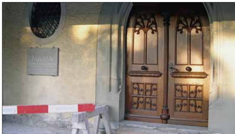
Die Renovationsarbeiten sind vorbei, die Wiedereröffnung steht bevor!
