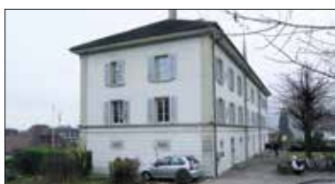
Das Priesterseminar St. Beat an der Adligenswilerstrasse 13 in Luzern.
