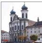
Die Jesuitenkirche wird innen und aussen saniert.
